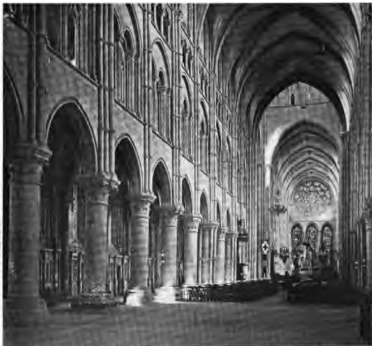
Fig. 151. — Voûtes sexpartites de la nef de la cathédrale de Laon. Amortissement de toutes les charges sur des colonnes monocylindriques.
